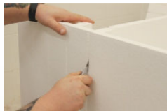
06 | PRZYCIĘCIE WYSTAJĄCYCH ELEMENTÓW NOŚNIKA 06 | TRIMMING PROTRUDING ELEMENTS OF THE CARRIER
