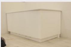
14 | NOŚNIK GOTOWY DO OBUXDOWY PLYTKAMI 14 | CARRIER READY FOR HOUSING PLATES
