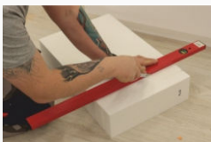
08 | PRZYCIĘCIE ELEMENTÓW 3 DO MONTAŻU W DNIĘ 08 | CUTTING OF ELEMENTS 3 TO MOUNTING IN THE DAY
