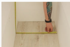
07 | ZEBRANIE WYMIARÓW SZEROKOŚCI DNA 07 | COLLECTION OF DIMENSIONS DNA WIDTH
